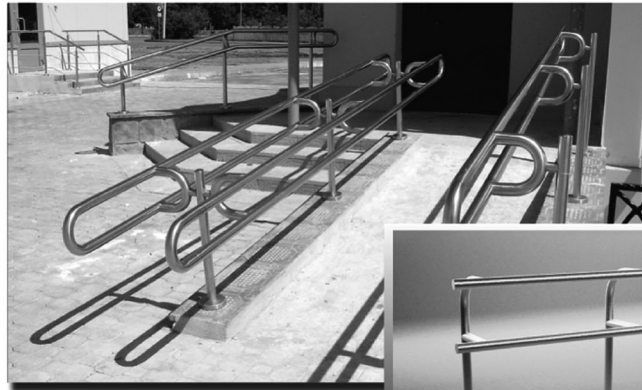
материал сталь 1.4301 (AISI 304) стойка и поручень - труба \varnothing 42.4
